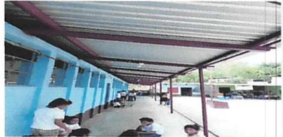
Foto 2: Cambio de techado y pintado de costaneras
