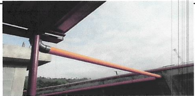
Foto 6: Instalación de canal y calda de agua pluvial
